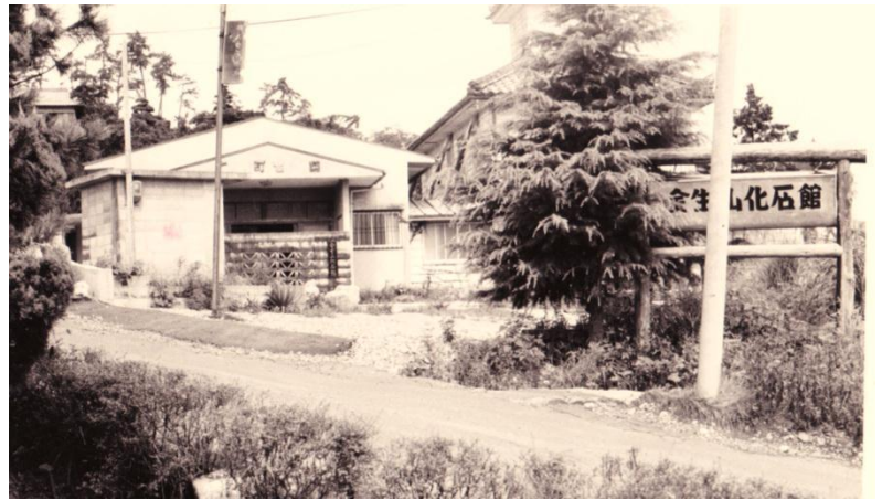
旧化石館（左側の産業館内に開設されました）
